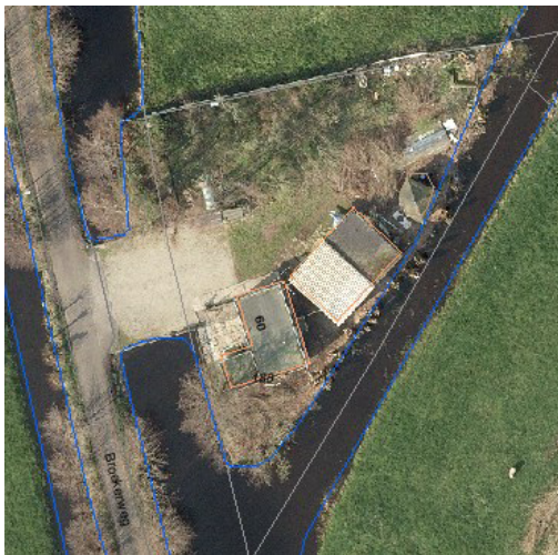
Afbeelding 1: luchtfoto 2014 huidige situatie
