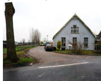
Bebouwing met de voorgevel op de weg gericht
