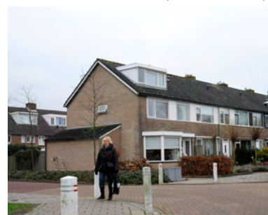
Uitbouw en dakkapel vormgegeven als ondergeschikt element
