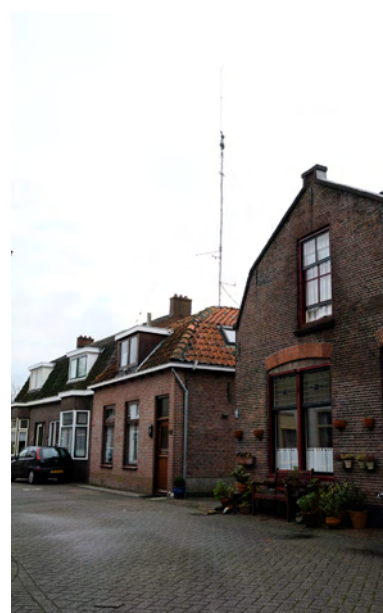
Antenne op het achtererf aangebracht
