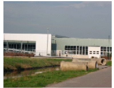
Grootschalige bedrijfshallen met representatieve gevels
