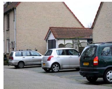
Toevoeging in de Meerkoet niet afgestemd op architectuur hoofdvolume
