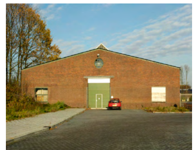
Grote bakstenen hallen aan de oostzijde van het terrein
