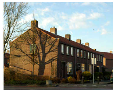
Schoorstenen geven ritme aan het straatbeeld
