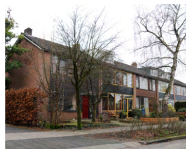
Gevels van baksteen en ingevuld met puien
