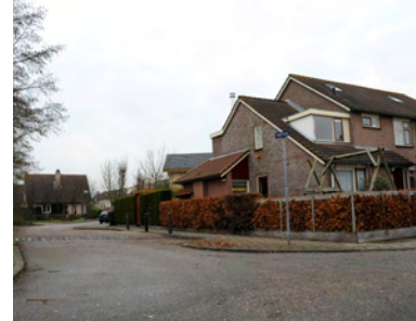
Uitbouw in stijl en afwerking niet afgestemd op architectuur hoofdvolume
