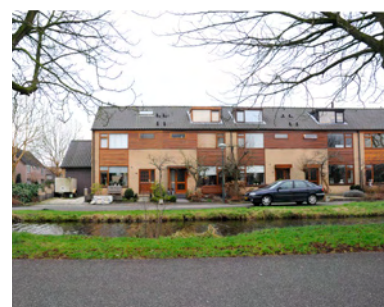
Gevels van baksteen en ingevuld met puien
