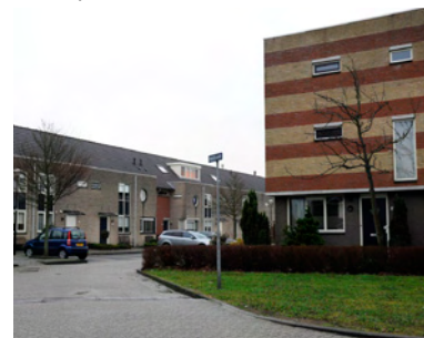
Metselwerk met vlakken in een afwijkende kleur
