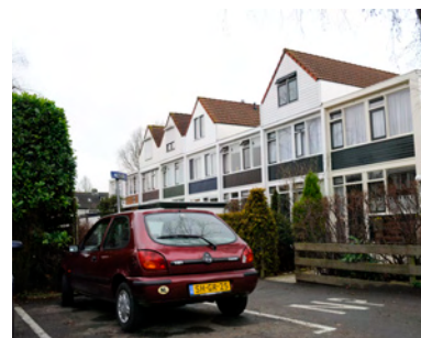
Cascowoningen in lange rijen met variërende bouwmassa
