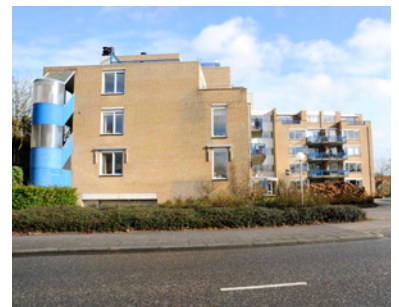
Appartementen aan Oudelandseweg
