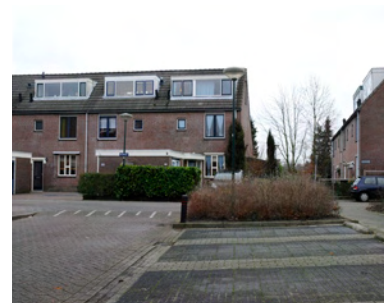
Een onrustig beeld door plaatsing van verschillende dakkapellen in één rij
