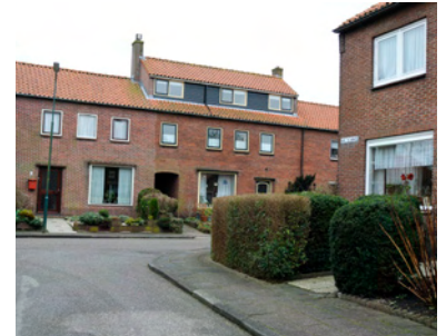
Rustig beeld van een dakopbouw die over twee woningen gelijk is uitgevoerd
