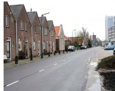
Gevels van woningen zijn van baksteen, daken voorzien van pannen
