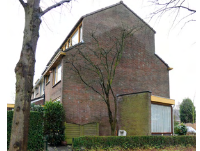
Dakopbouwen ook uitgevoerd tot aan het einde van het blok
