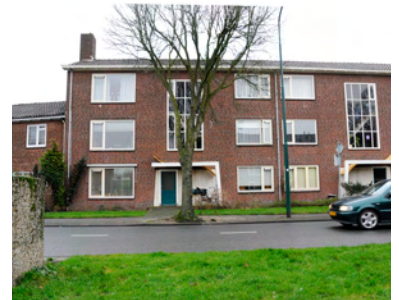
Appartementengebouwen hebben een onderbouw tot drie lagen
