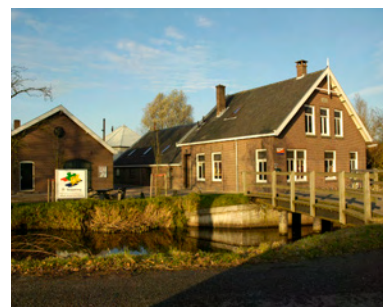
Woonhuis en stal niet uit één kap
