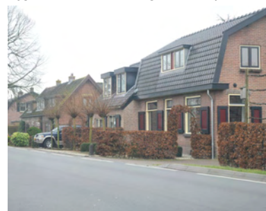
Woningen bestaan uit één tot twee lagen met een kap
