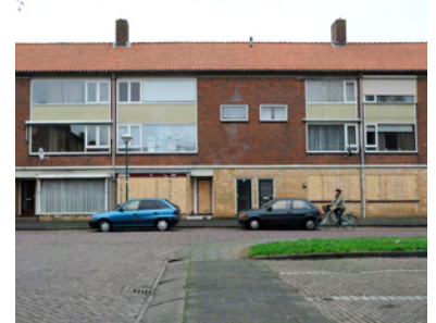
Blokgewijze herstructurering van gestapelde woningen in de Rubensstraat
