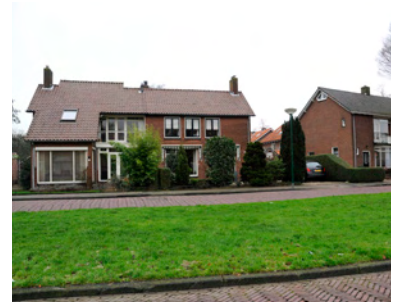
Eenheid in straatbeeld is verloren door gebrek aan samenhang aanpassingen
