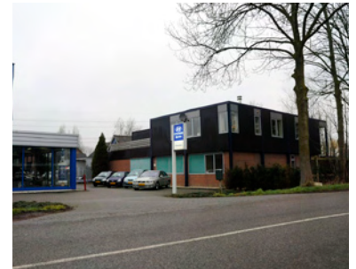
Bebouwing in het noordelijke deel
